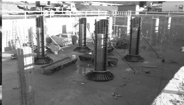
Obr. 8. ÚV Plzeň - rekonstrukce AKU B
