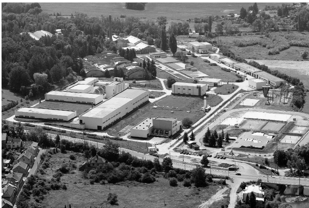
Obr.1. Areál úpravní vody Plzeň
