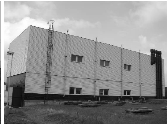
Obr. 4. ÚV Plzeň – objekt ozonizace
